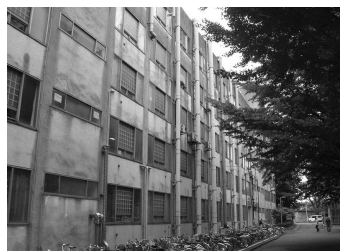
▲老朽施設の外観（経年48年）
