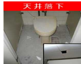
■床スラブ 経年31年 上階の便器固定用モルタルの落下により、天井を突き破り床まで落下。
