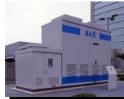
電力貯蔵用ナトリウム 硫黄 (NAS) 電池
