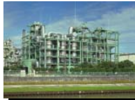
下水処理プラント
