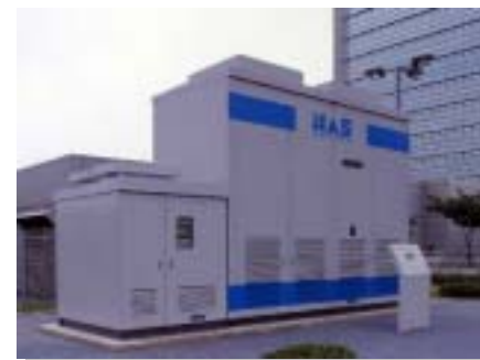
電力貯蔵用NAS電池
