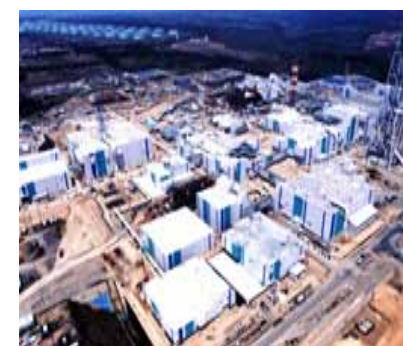
六ヶ所再処理工場
