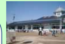
市民出資による太陽光パネル設置
