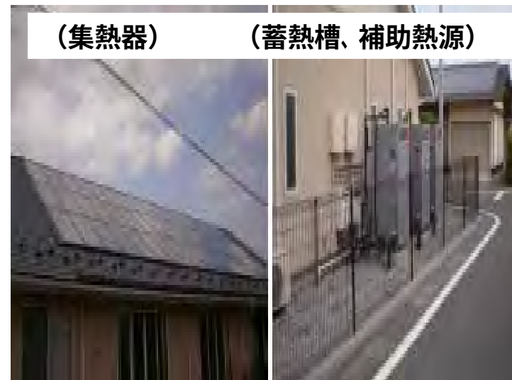
図3 老人ホームへの設置例（長野県） 16
