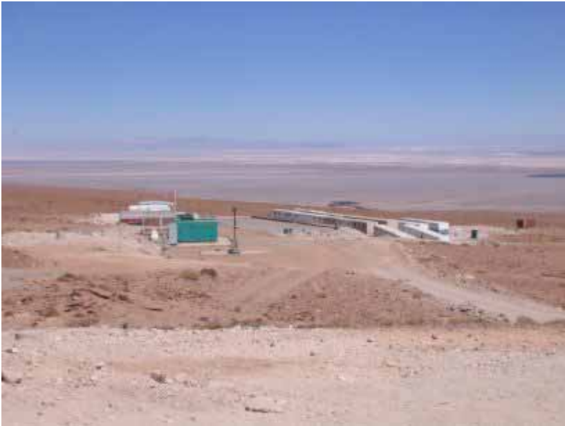
建設キャンプ、仮設発電機、 宿舎など
