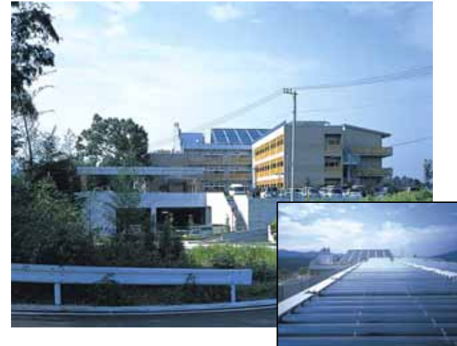
設置事例3 (福祉施設)
