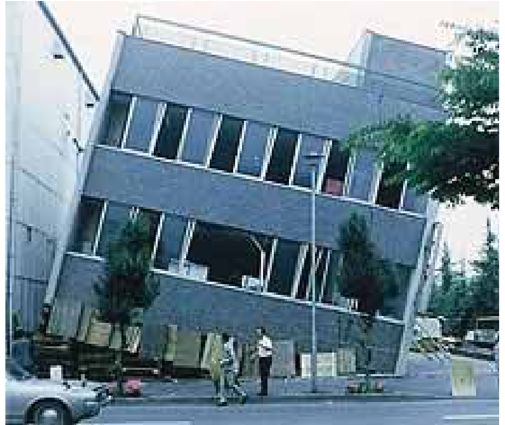
宮城県沖地震（1978） 〔ピロティ部分の崩壊〕
