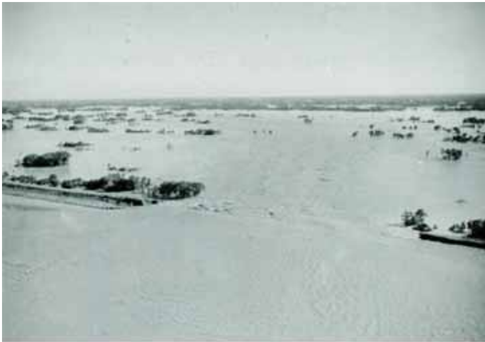
利根川決壊口。手前が利根川本流で右から左に流れている、中央左右が340mにわたって決壊した堤防、画面上部が洪水に飲まれた民家と田畑。撮影GHQ (提供：国土交通省関東地方整備局利根川上流河川事務所)
