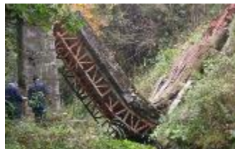
香川・徳島県境 無名橋 (鋼2径間単純トラス橋) の落橋(H19年)
