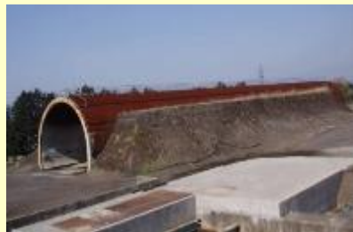
施工総研内模擬トンネル (静岡県)
