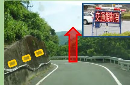
電光標識、反射材等の設置により安全な避難を確保
