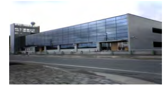
東通村防災センター
