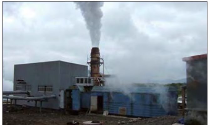
択捉島・地熱発電所
