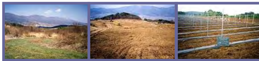
造成前 造成中 造成後
