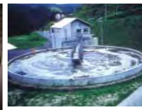
畜産環境対策施設
