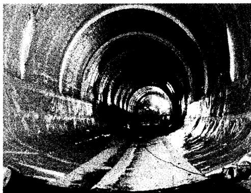
都市部でのNATM工法によるトンネルにおいて、漏水のない極めて高度な止水性をもった防水工法を開発。
