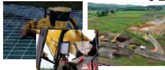
ICT建機での施工
