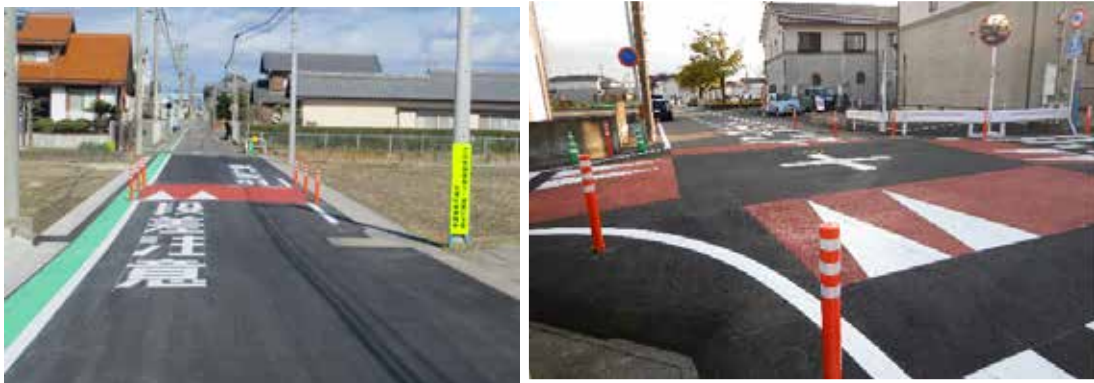
図 5-24 ハンプ設置後の様子
