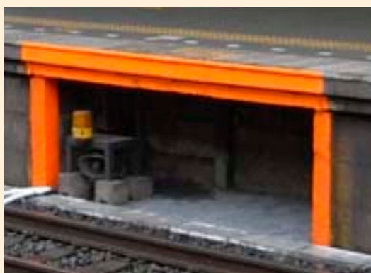
ホーム下の待避スペース
