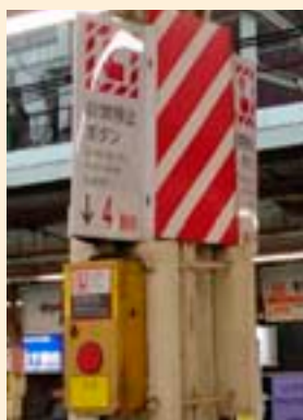
非常停止押しボタン
