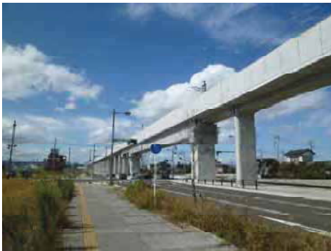
図 2-1 単線高架橋（仙台空港鉄道）
