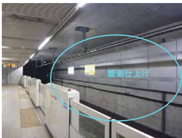
図 2-13 ホーム対向壁の簡素化事例
