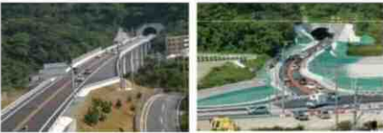
伊差川IC交差点から名護大北トンネルを望む 世富慶IC交差点から幸地又トンネルを望む
