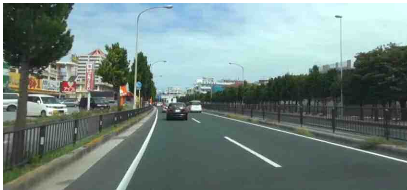
図 名護付近の国道 58 号の状況（許田方向から名護方向を望む）
