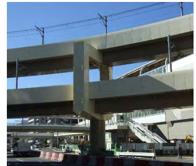
写真 京急蒲田駅付近 単線2層高架構造
