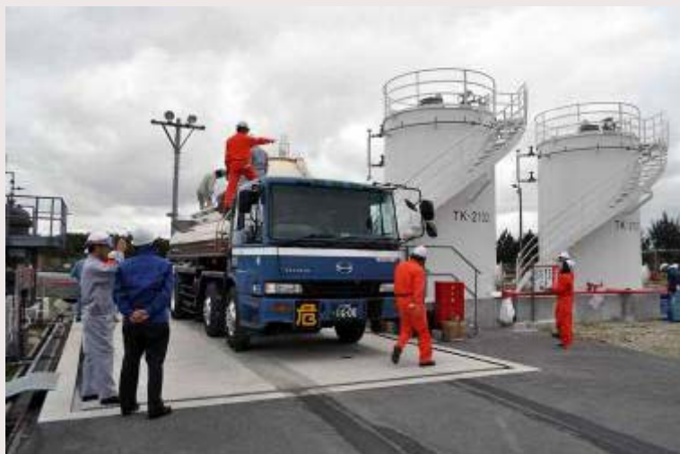
エタノールタンク
