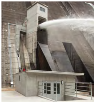
【発電設備の新設・増強】
