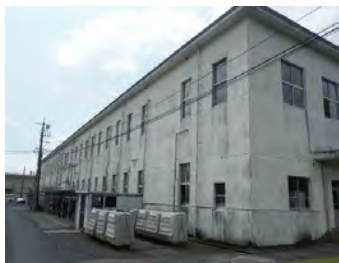
【現状施設の例(庁舎)】
