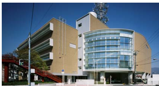
消防庁舎外観
