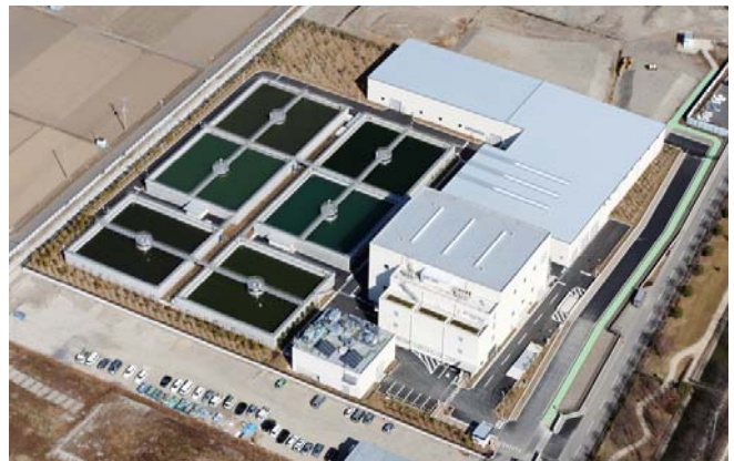
浄水場（航空写真）
