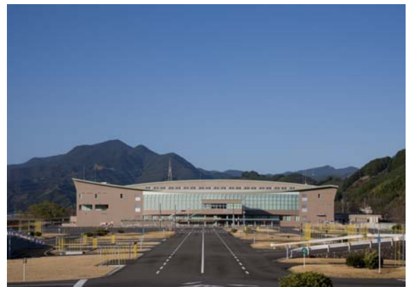
中部免許センター外観
