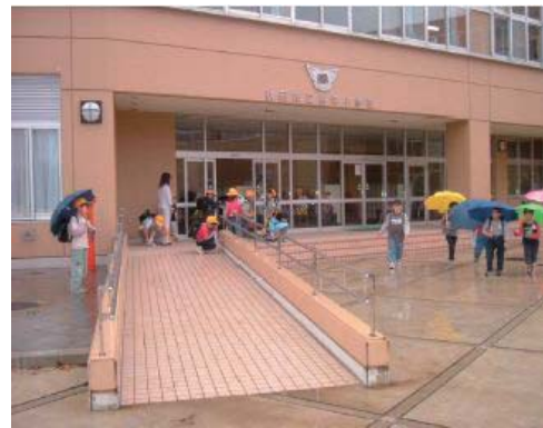
学校施設のバリアフリー化の事例（スロープの設置）
