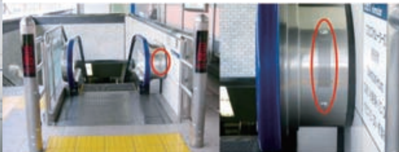
エスカレーターの音声装置（埋込型）
