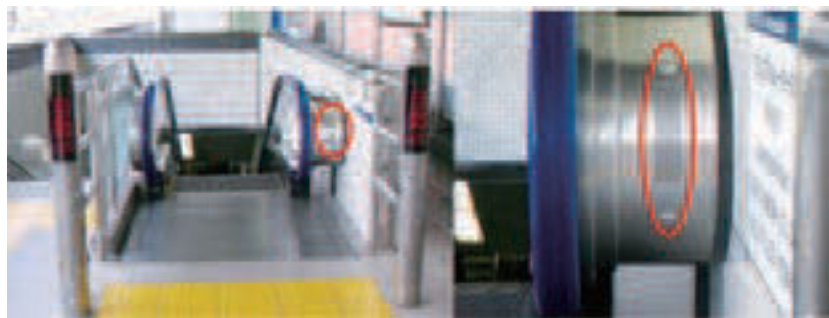
エスカレーターの音声装置（埋込型）
