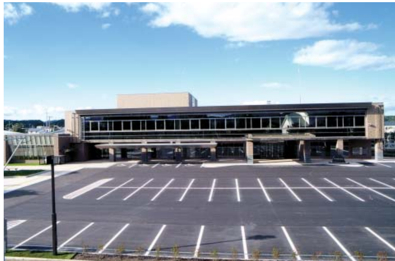
役場庁舎・総合福祉センター「うらら」全景 （ハートビル法・北海道福祉のまちづくり条例認定）
