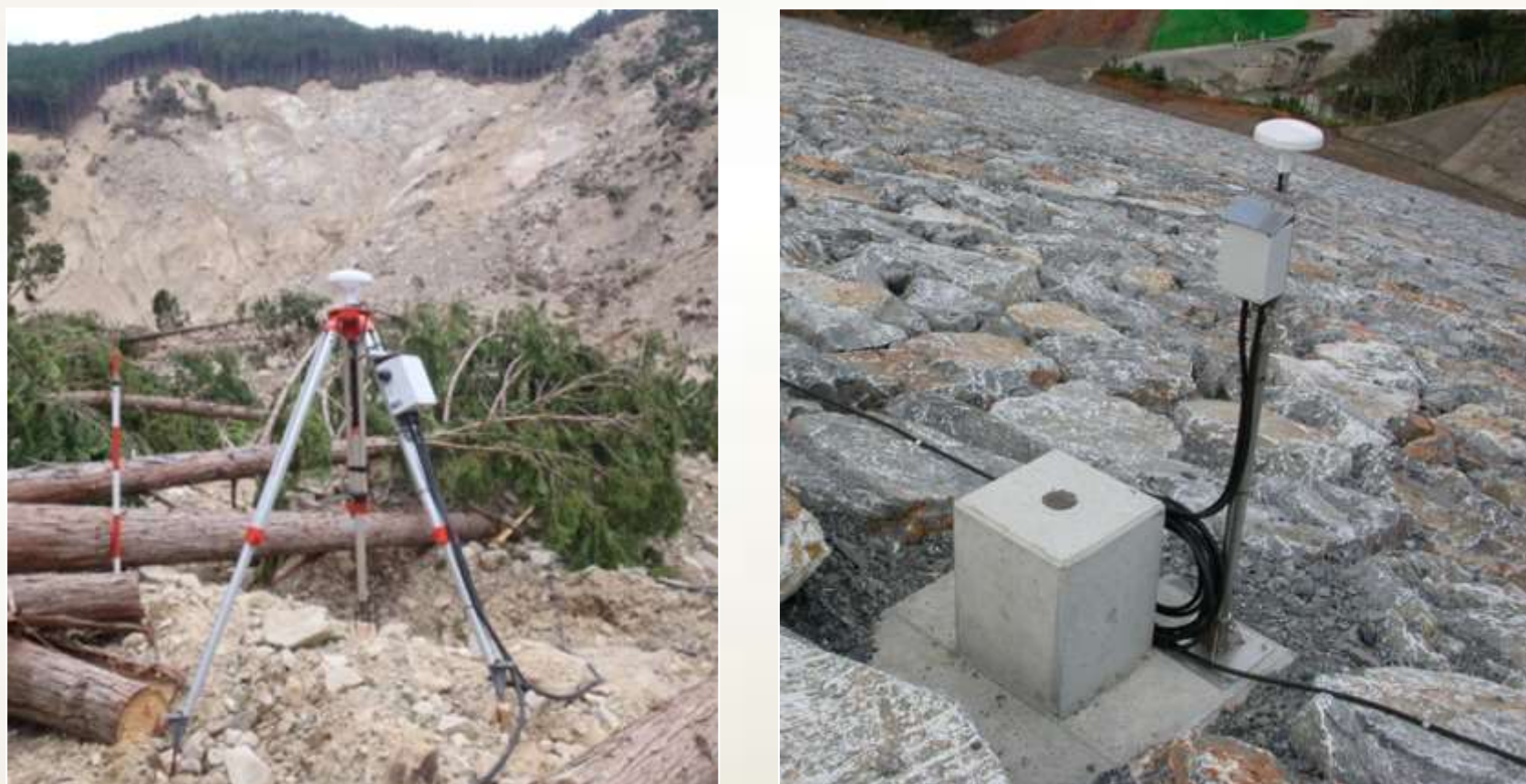
現場設置事例 (左:土砂災害現場 右:フィルダム堤体)
