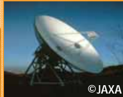
©JAXA 深宇宙探査用 64mアンテナ設備
