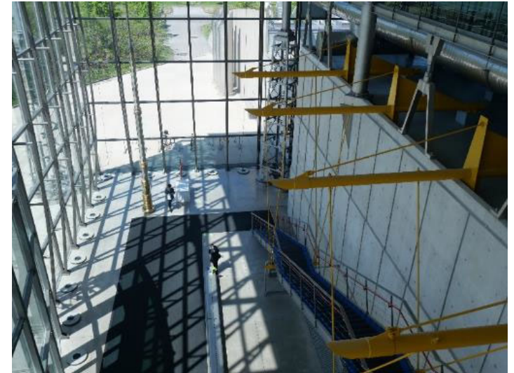
↑5階から見たエントランス。外壁はガラスとステンレスでできている。
