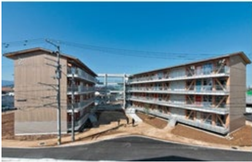
4階建て共同住宅 準耐火構造の現し木造4階建て （2023：徳島県新浜町）
