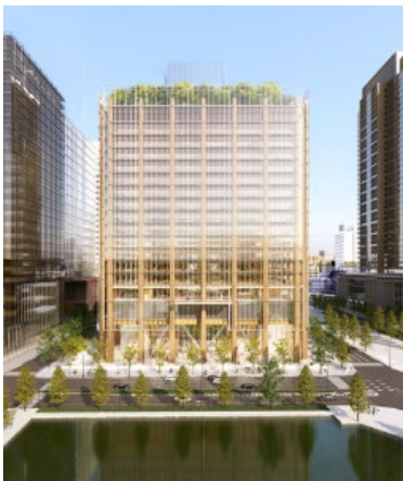
日本初の高さ100mを超える 超高層木造（20階建て） （施工中：東京都千代田区）
