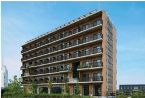
6階建て共同住宅 木造・鉄筋コンクリート造の混構造 （2025：茨城県つくば市）
