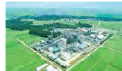
南長岡ガス田 越路原プラント
