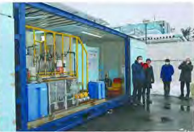
バイオ産業の実証事業で使用される廃水処理の膜分離リアクター＝長岡市寿3
