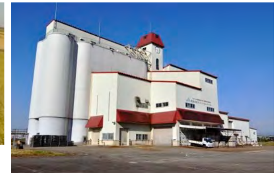
コメを荷受・乾燥・貯蔵・調整する カントリーエレベーター
