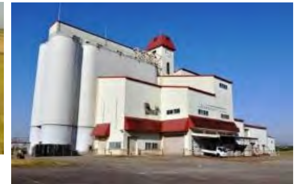
コメを荷受・乾燥・貯蔵・調整するカントリーエレベーター
