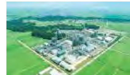
南長岡ガス田 越路原プラント
