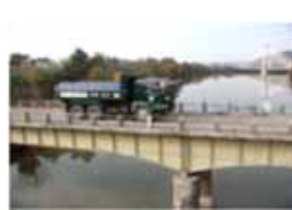
撤去予定橋梁を用いた载荷試験
