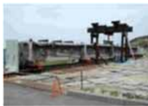
損傷部材を用いた载荷試験
