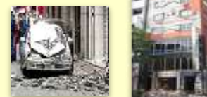
＜東日本大震災等における外装材の落下＞
