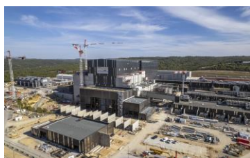
ITERサイトの建設状況
