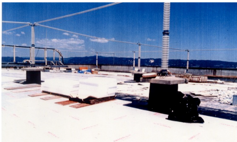
実験棟屋上の遮蔽補強工事 (白い板はポリエチレン板)
