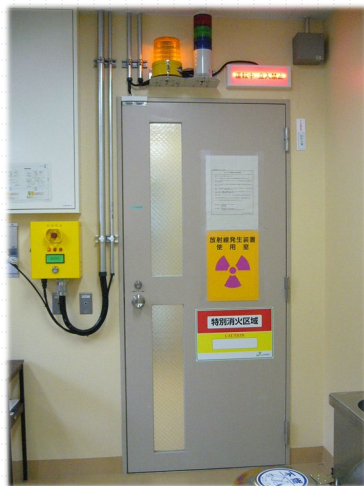
インターロックエリアの出入口
