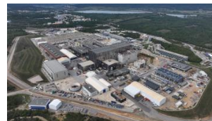
ITERサイトの建設状況
