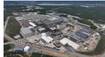
ITERサイトの建設状況
