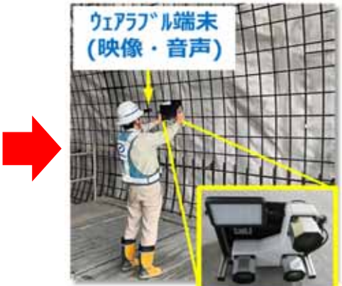
鉄筋計測 (新技術活用)
