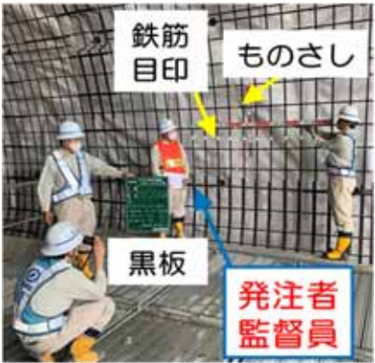
鉄筋計測 (従来)
