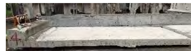
土砂化した床版に舗装し、床版調査の際の降雨の影響を確認
