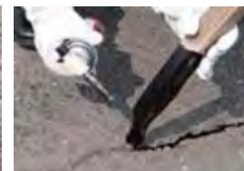
充填材 (検証予定の工法)
