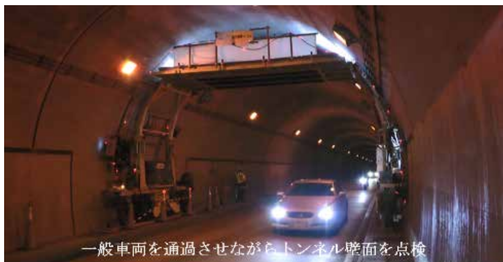
図 3-102 トンネル全断面点検・診断システム
