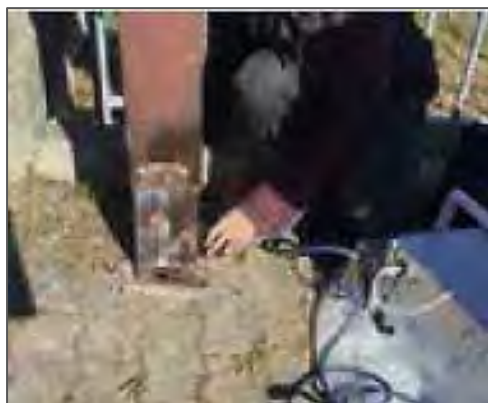
図 3-101 高感度磁気非破壊検査
