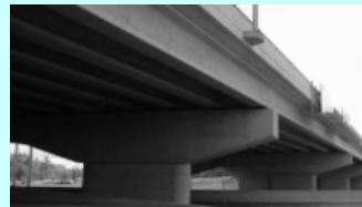
高架環境(危険誤判定)
