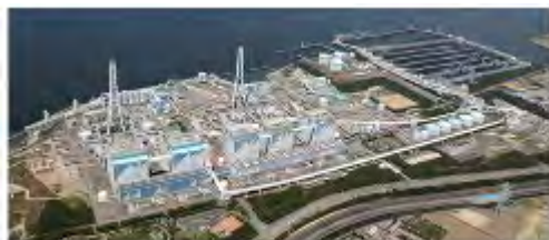
碧南火力発電所（第4号機）
