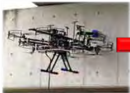
ドローンによる 点検
