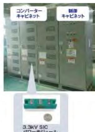
図 3-21 6.6kV 級トランスレス電力変換器
