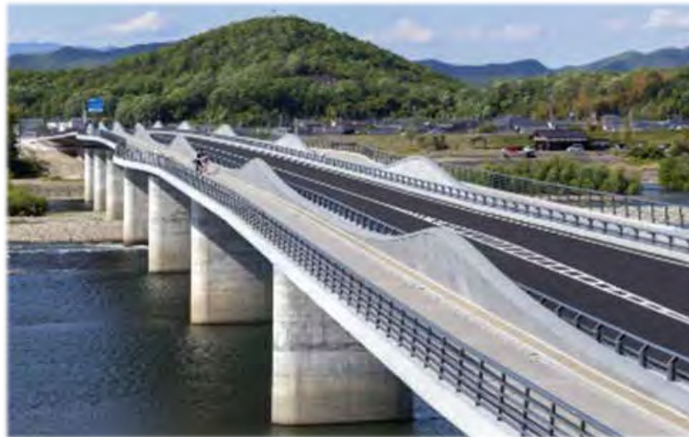
図 3-106 フィールド試験が行われた各務原大橋
