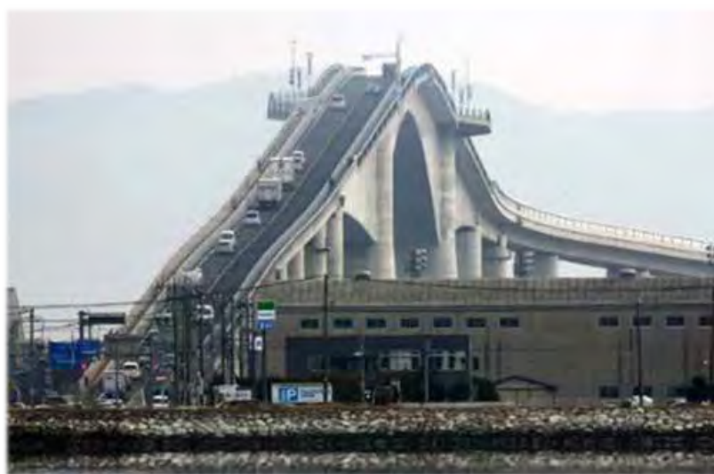
図 3-107 フィールド試験が行われた江島大橋
