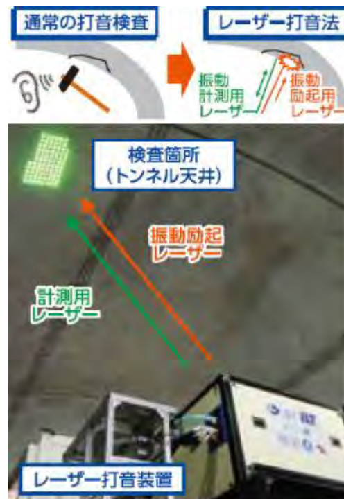
図 3-96 ハイパワーレーザーによるトンネル打音検査
